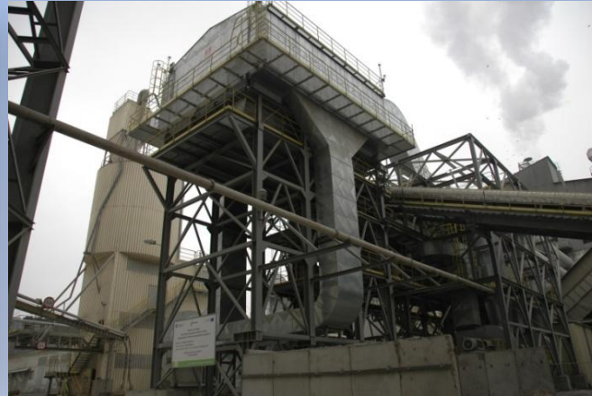
LAFARGE CEMENT PLANT S.A. MAŁOGOSZCZ
